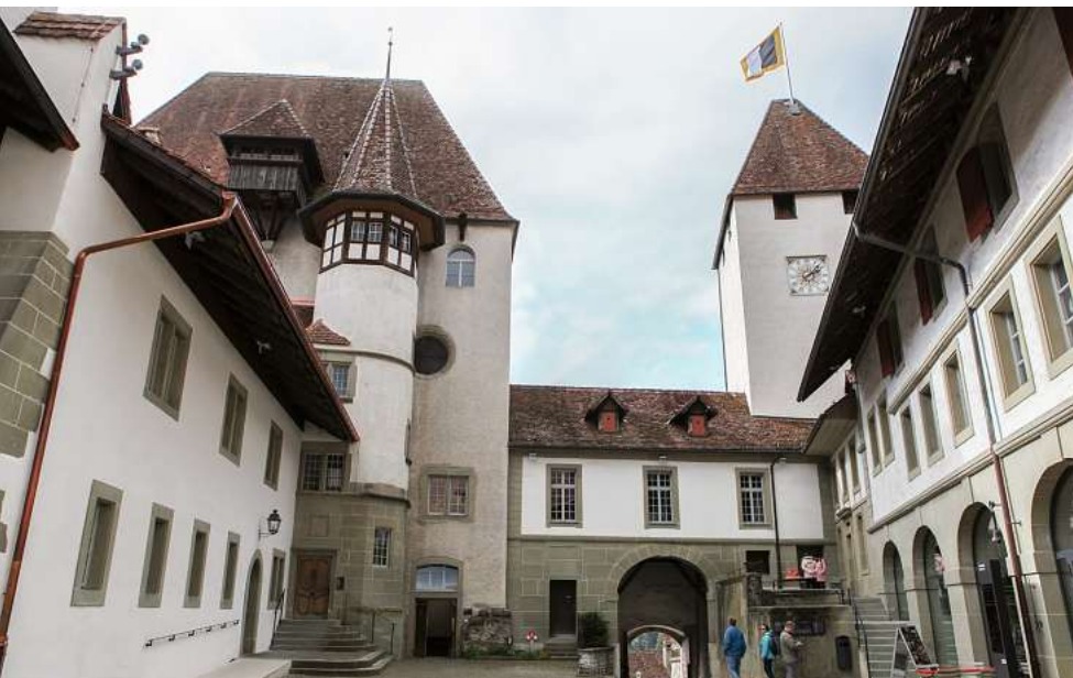
La cour intérieure du château de Berthoud.
