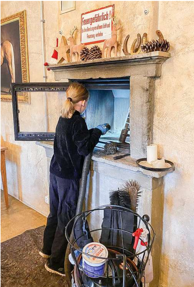
Nevia en train de nettoyer une cassette de cheminée à l'aide d'un aspirateur et d'une brosse.
