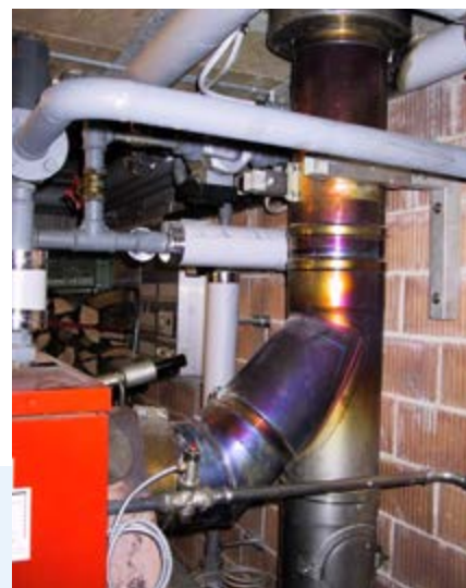
Farbveränderung an Edelstahlkamin Modification de la couleur d'une cheminée en acier inoxydable
