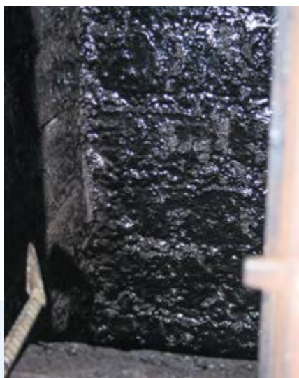
Glanzruss im Kamin Suie cristallisée dans la cheminée
